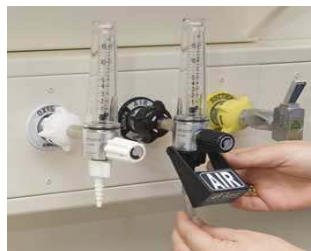
Slika 3: Vtičnice za kisik in zrak
